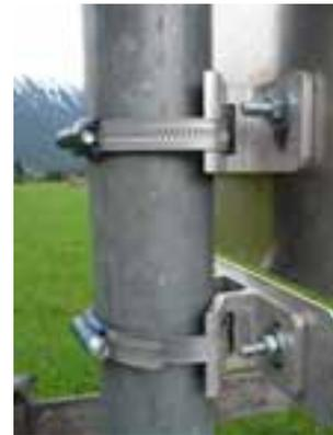
Abbildung 25: Beispiel zur Montage eines MTB Schildes
